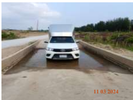
ภาพที่ 2-4 การทำความสะอาดล้อรถบรรทุก
