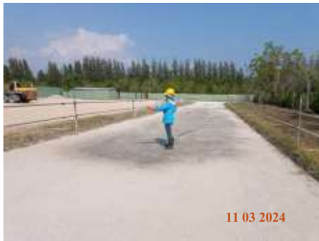
ภาพที่ 2-1 การฉีดพรมน้ำในพื้นที่ก่อสร้าง และทางเข้า-ออก พื้นที่ก่อสร้าง
