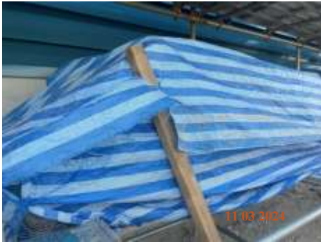
ภาพที่ 2-7 ผ้าใบหรือผ้าพลาสติกปิดคลุมกองดิน หรือกองวัสดุก่อสร้าง
